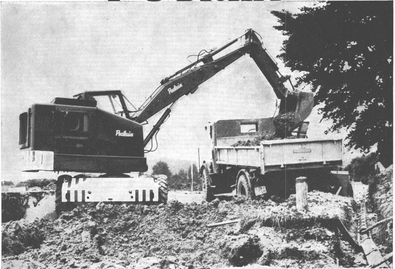
Unser Bild: Verladearbeiten im Strassenkoffer
