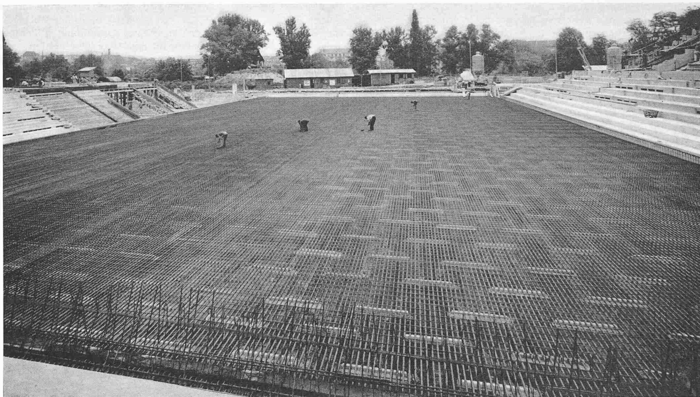
Bild 14. Kunsteisbahn Genf. Ansicht der Piste nach Verlegen der Kühlröhren, vor dem Betonieren der Platte
