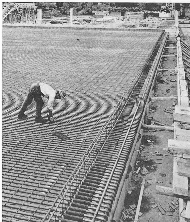
Bild 15. Kunsteisbahn Genf. Links Piste mit Kühlröhren auf Betonklötzen und Querarmierung, rechts Leitungskanal
