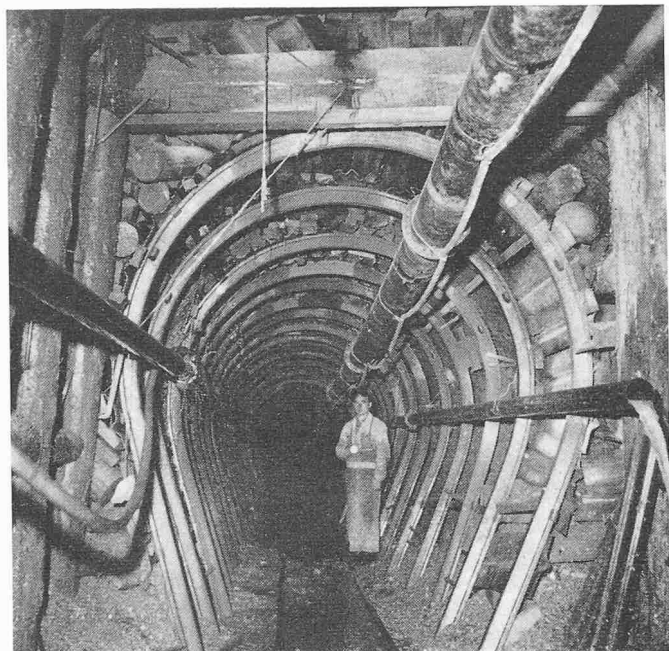
Bild 8. Druckstollen zwischen Teufelau und Wasserschloss Birch-lai, Bauzustand 8. Nov. 1958
