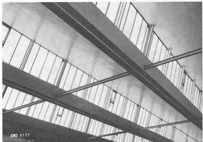
Bild 9. Innenansicht einer Shedhalle mit Fachwerkunterzügen. (Shedhalle für Firma Isofirm AG., Reinach)
