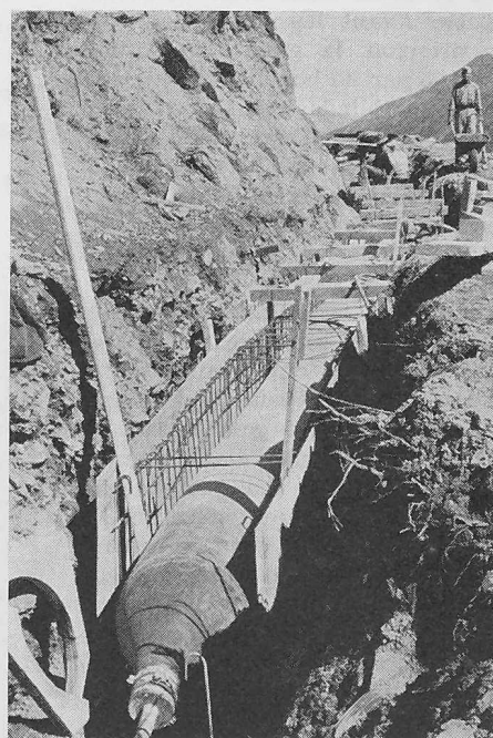
Fig. 12. Conduite à flanc de coteau de Blumatt, coffrage «Ductube» Ø 60 cm
