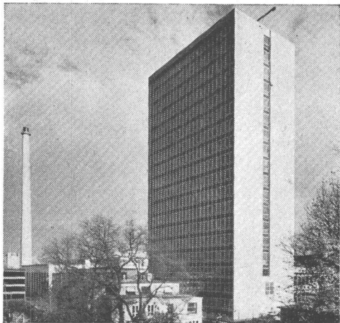
Im Hochbau für hohe Festigkeiten
