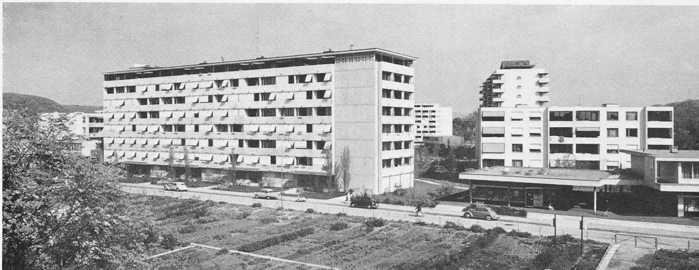
Ansicht der Ueberbauung aus Südwesten, rechts Ladenbauten
