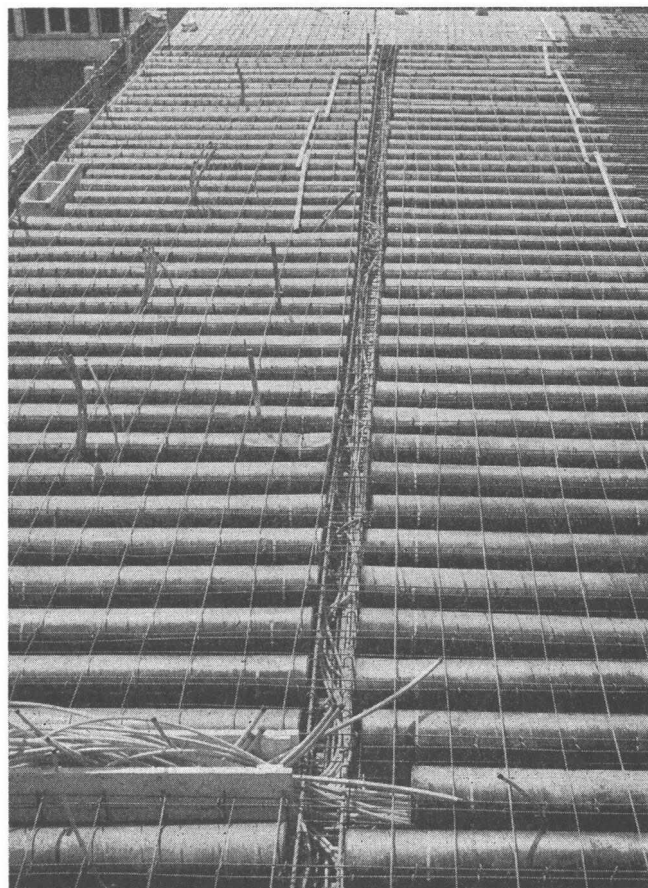
Neubau Ringier & Cie. AG, Zofingen, 3 Decken à ca. 700 m Rohr, 32 cm \phi
