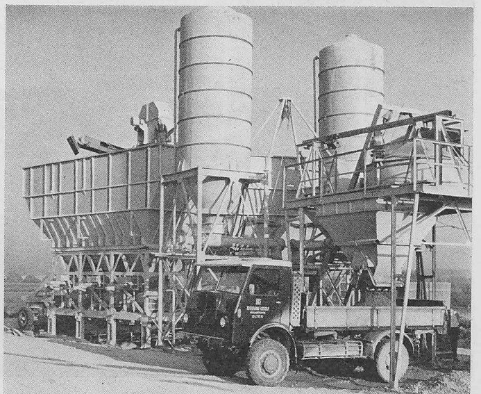
Bild 7. Vollautomatische transportable Mischanlage mit Materialsilos und Zwangsmischer für rd. 25 m 3 /h Beton. Bedienung 2 Mann
