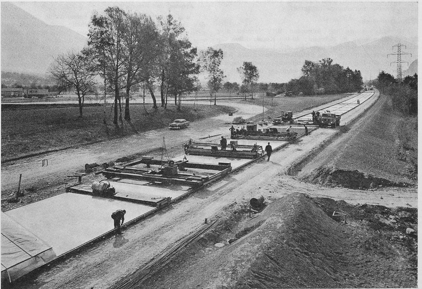
Bild 10. Nationalstrasse Nr. 13 beim Anschlussbauwerk Maienfeld, Blick gegen Landquart. Von rechts nach links d. h. von hinten nach vorn im Bilde: auf Plastikfolie verlegte untere Fugeneinlagen (Welleternitstreifen), Lastwagen beim Beladen des Betonverteilers, Betonstrassenfertiger, Fugenvibriergerät, Längsfertiger, Steg zum Aufspritzen des Schutzfilmes (curing), Schutzdach
