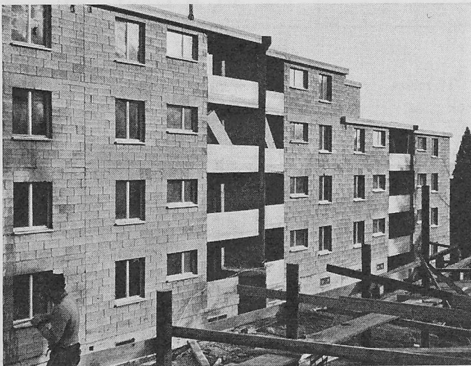
Block A im Bau aus Norden gesehen
