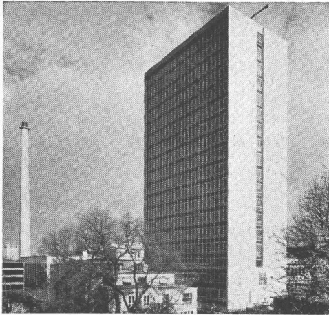
Im Hochbau für hohe Festigkeiten
