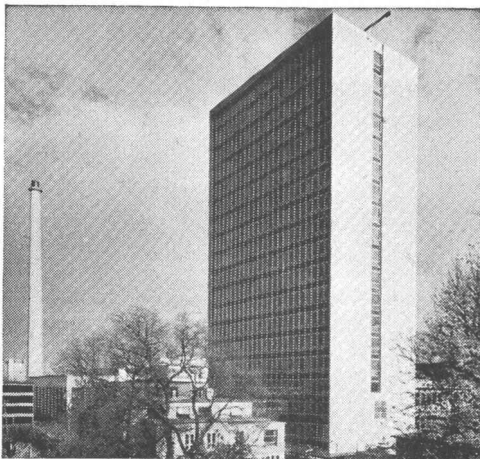
Im Hochbau für hohe Festigkeiten
