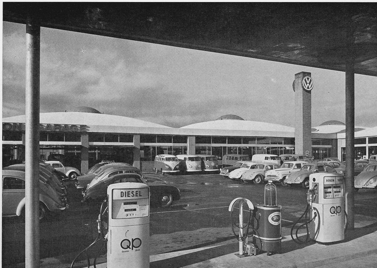
Ansicht von der Tankstelle gegen den Werkstatt-Trakt
