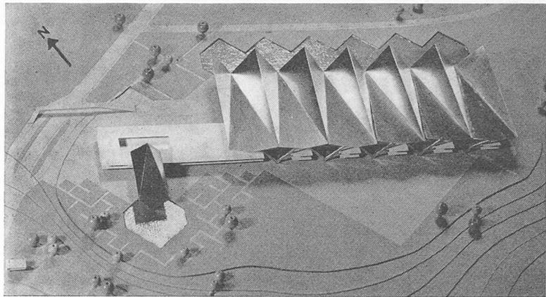
Konstruktion: Untergeschoss und Galerie in Spannbeton. Grosse Halle sowie Kongress-Saal in dreidimensionalem Gitterwerk aus Stahl. Hallenfassade mit maximal grossen Glasscheiben, hängend montiert.
