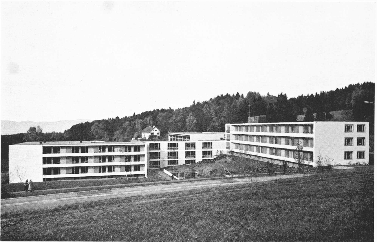
Ostansicht der Bauanlage, im Vordergrund Zufahrtsstrasse. Zwischen den Bettentrakten Süd und Ost der Verbindungsgang, dahinter der Saal
