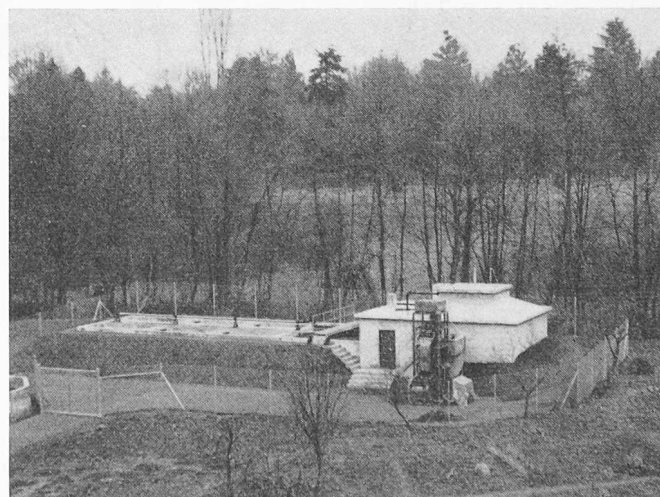
Bild 2. Biologische Kläranlage Hermance
