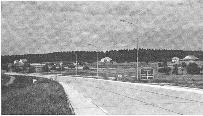
Bild 3. Parallel mit dem Bau der Nationalstrasse Winterthur—Schaffhausen ist die nördlich der Thur (Weinlandbrücke) gelegene Gemeinde Kleinandelfingen zusammengelegt worden. Vorsorglicher Landerwerb und enge Zusammenarbeit der zuständigen Organe ermöglichten es, den für die Strasse erforderlichen Boden bereitzustellen und 6 Landwirtschaftsbetriebe aus dem Dorfe in die vom Durchgangsverkehr abgeschnittenen Wirtschaftsgebiete zu verlegen. Das Bild zeigt einen Ausschnitt aus dem neu entstandenen Siedlungsgürtel an der nordöstlichen Peripherie der Gemeinde
