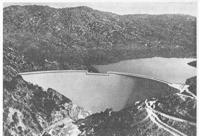
Bild 2. Staumauer Malpasset vor dem Bruch
