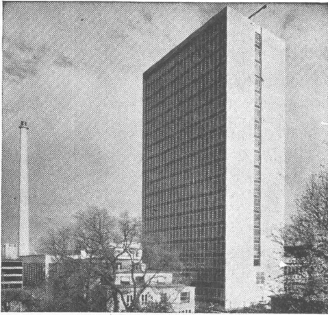
Im Hochbau für hohe Festigkeiten
