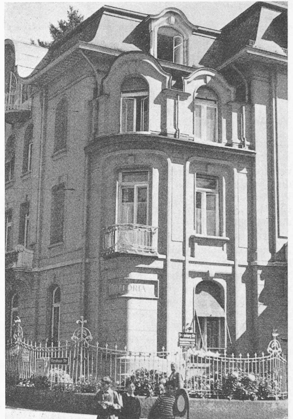
Bild 3. Uebergang von der Süd- zur Westfassade
