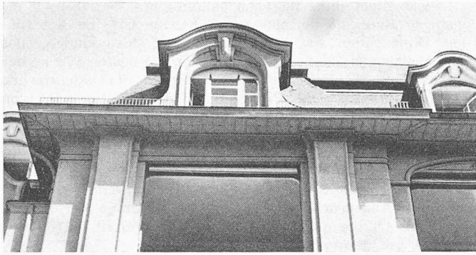
Bild 18. Dachpartie der Südfassade
