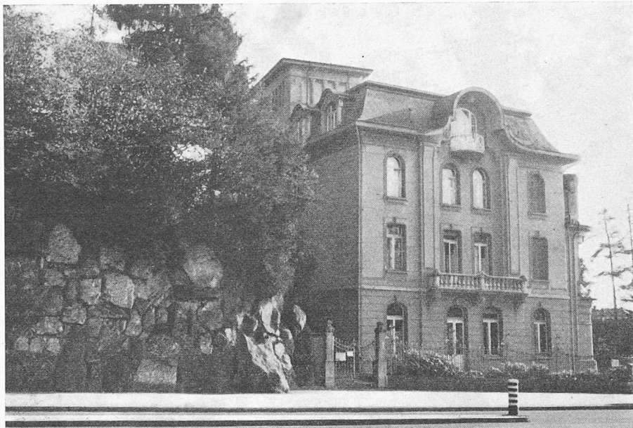
Bild 8. Westfassade (Kornhausstrasse) mit dem «Heilsarmeehut»
