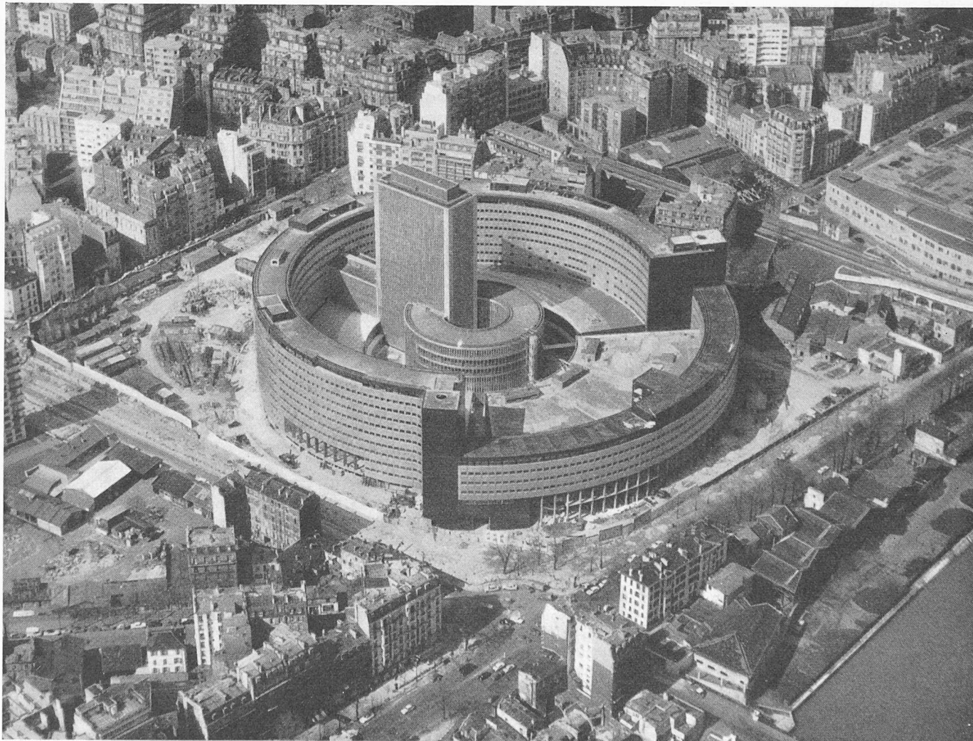
Das Radiogebäude in Paris, Quai de Passy (rechts unten die Seine), aus Süden
