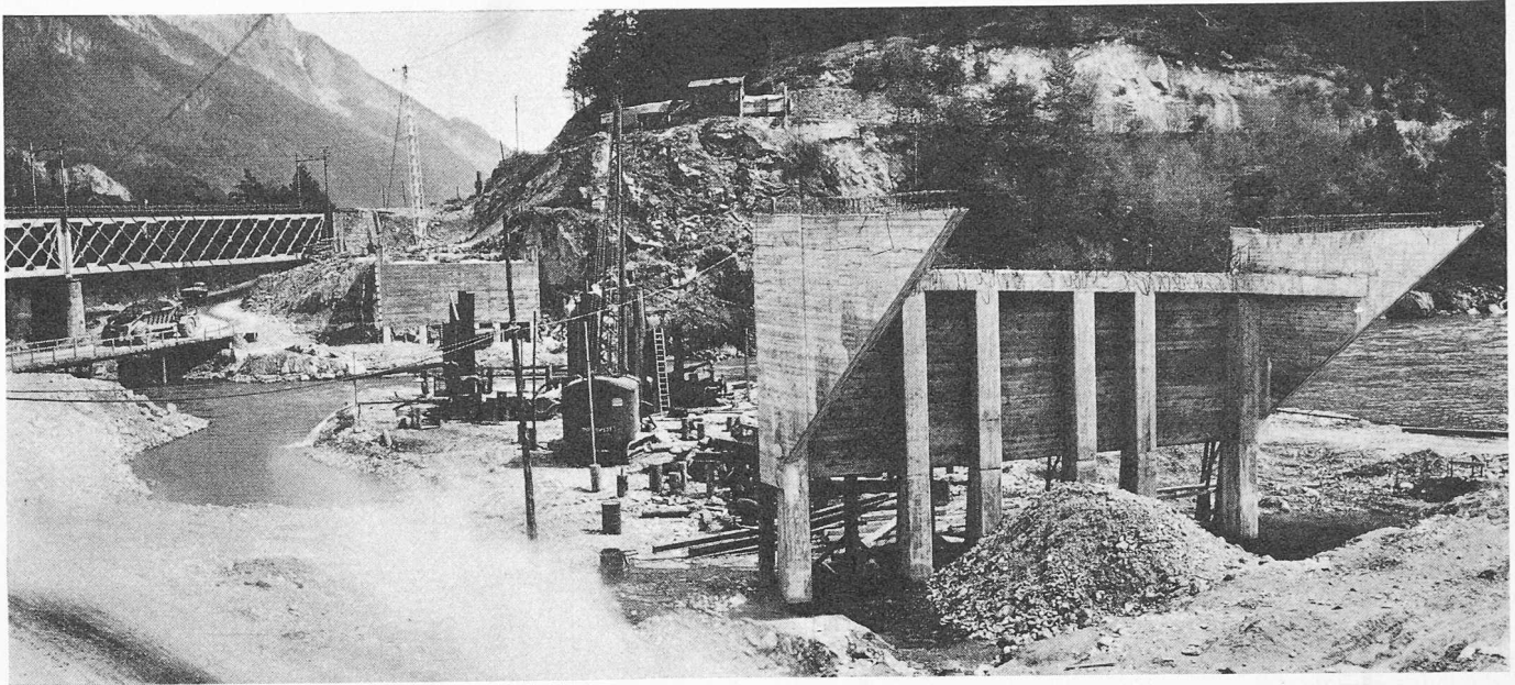
Bild 8. Hinterrheinbrücke Reichenau der N13, Bauzustand am 17. April 1963
