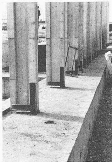
Bilder 5 und 6. Auflagerung der Binderfüsse im Bankett
