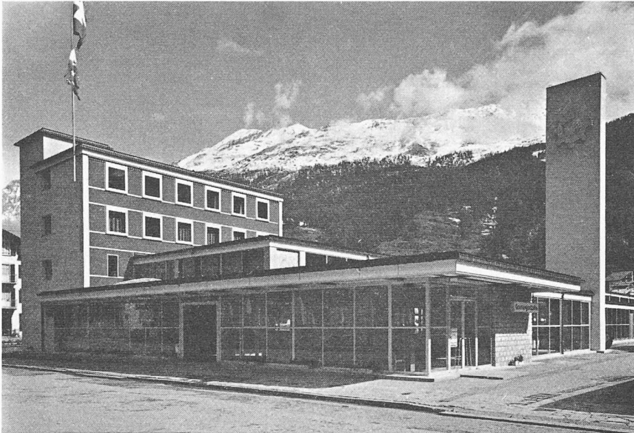
Bild 14. Nordwestansicht des neuen Stationsgebäudes. Links das Wohn- und Bürogebäude
