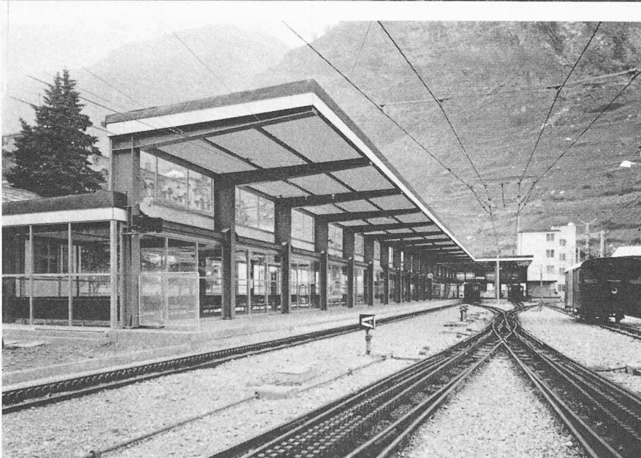
Bild 16. Das auskragende Bahnsteigdach
