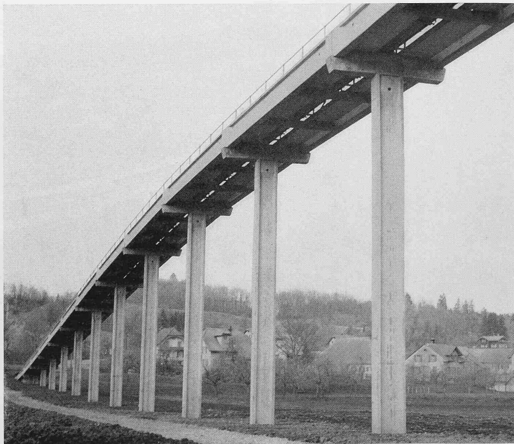
Bild 14 (oben). Aarebogen flussabwärts gesehen, im Hintergrund die Strassenbrücke und das Schloss Wildegg
