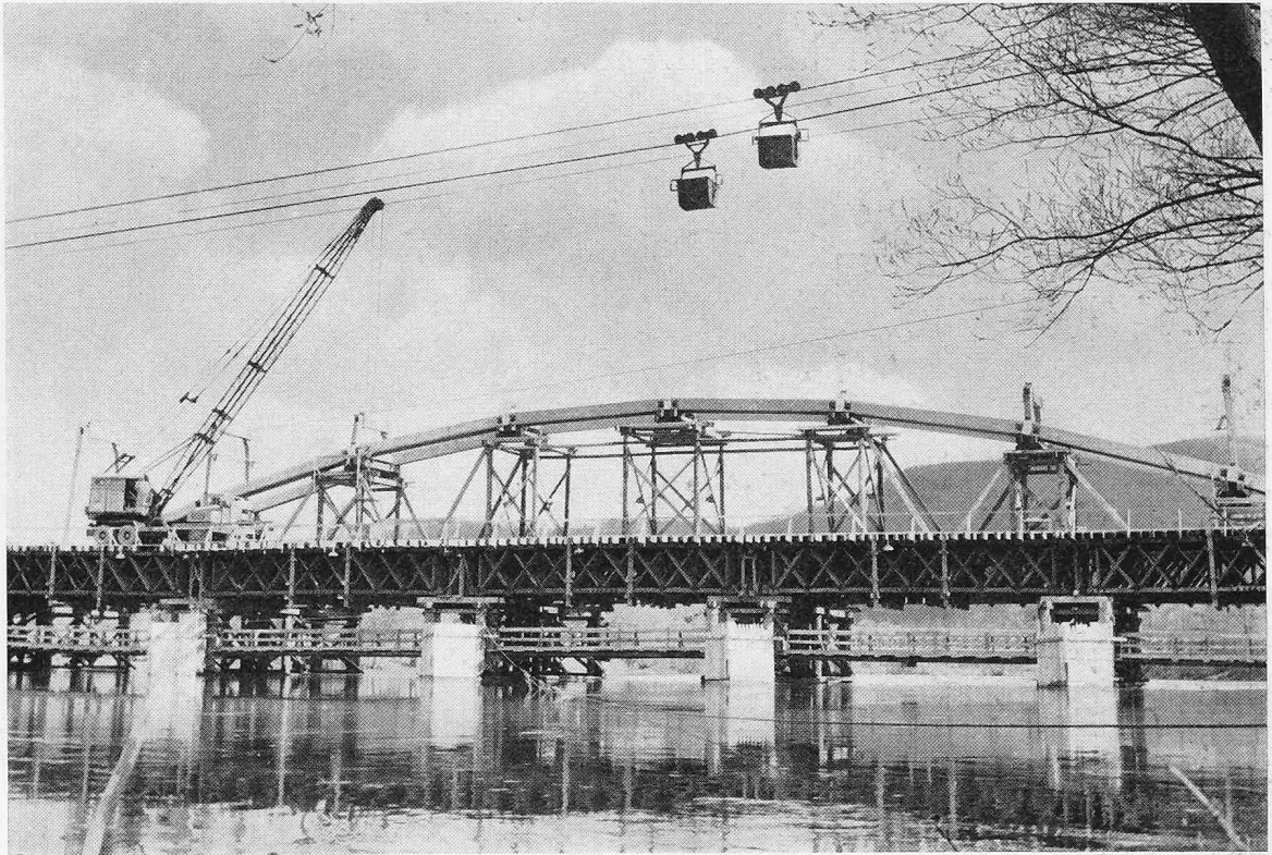
Bild 5. Ansicht des Montagegerüsts von Oberwasser
