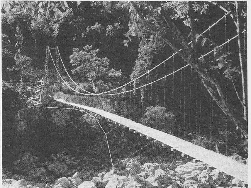
Bild 4. Brücke über den Marsyandi-Fluss, Länge 90 m, Breite 1,35 m
