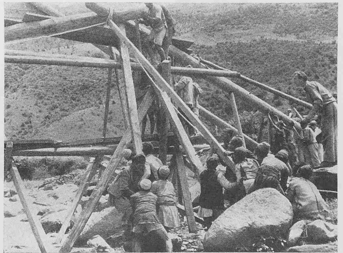
Bild 2. Brückenbau in Jiri
