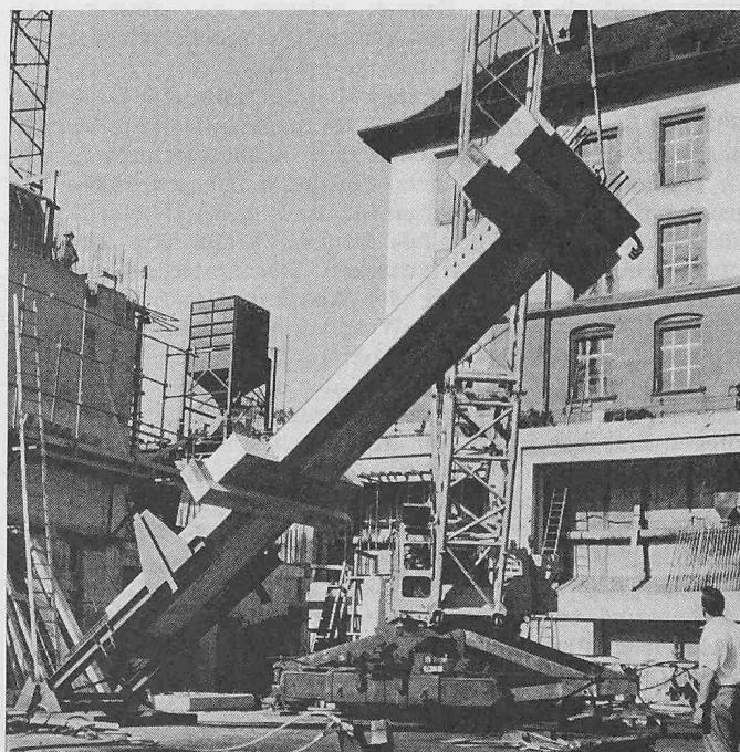
Bild 37. Aufrichten einer Kellerstütze durch den 60-t-Mobilkran
