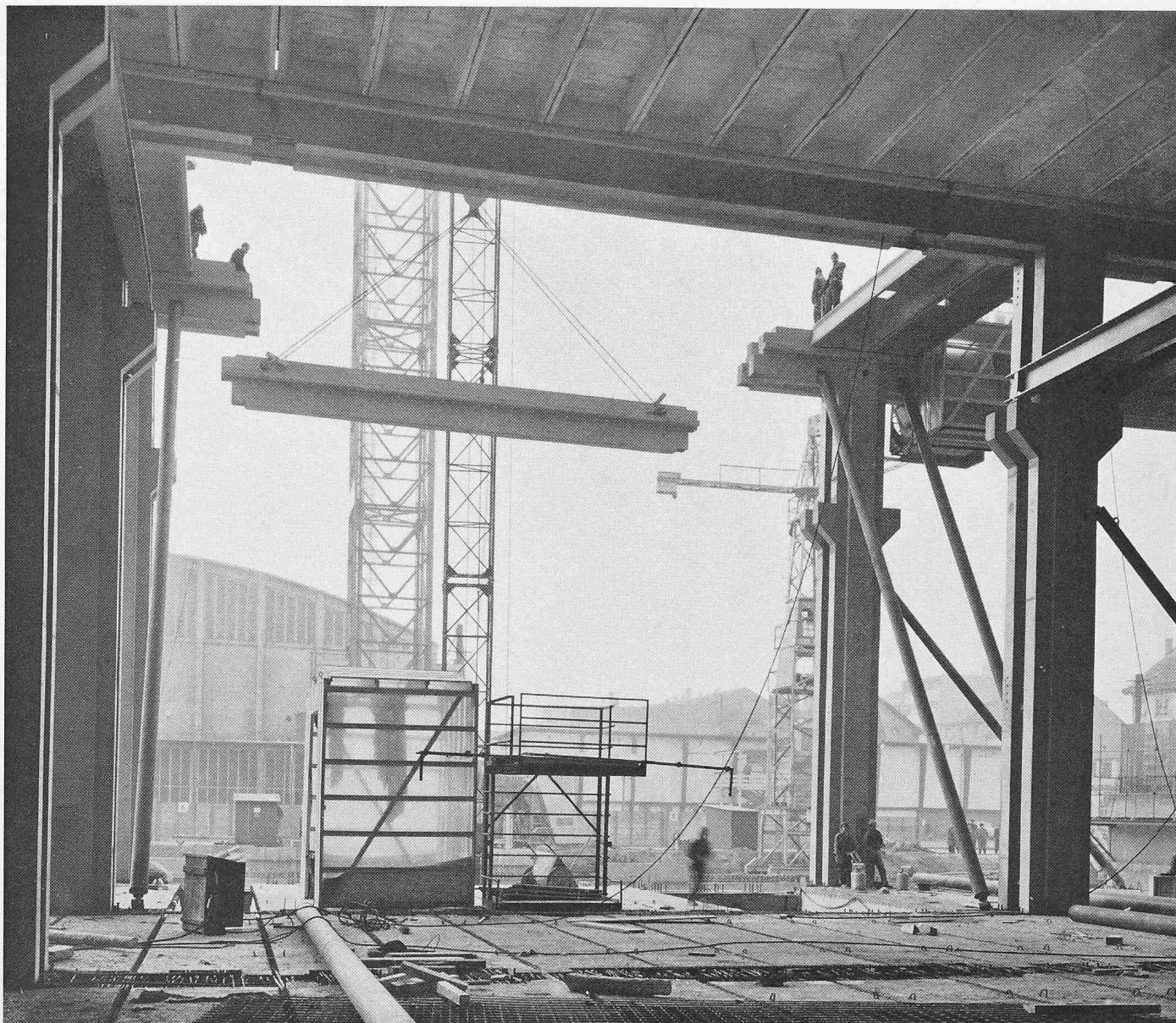
Blick vom Erdgeschoss aus auf das Einhängen eines Unterzuges auf die Stützenkonsolen. Die sichtbaren Siederohre dienen zum Richten der Stützen und als Verband bis zur Verbindung der Rahmen durch die Rippenplatten. Foto Hoffmann, Basel
