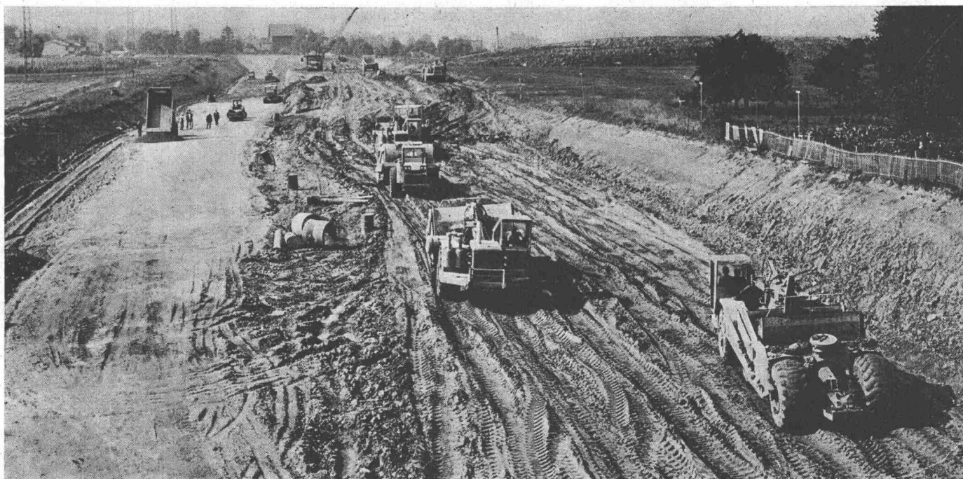
AUTOBAHN GENÈVE-LAUSANNE Anfangsstrecke des Genfer Abschnittes
