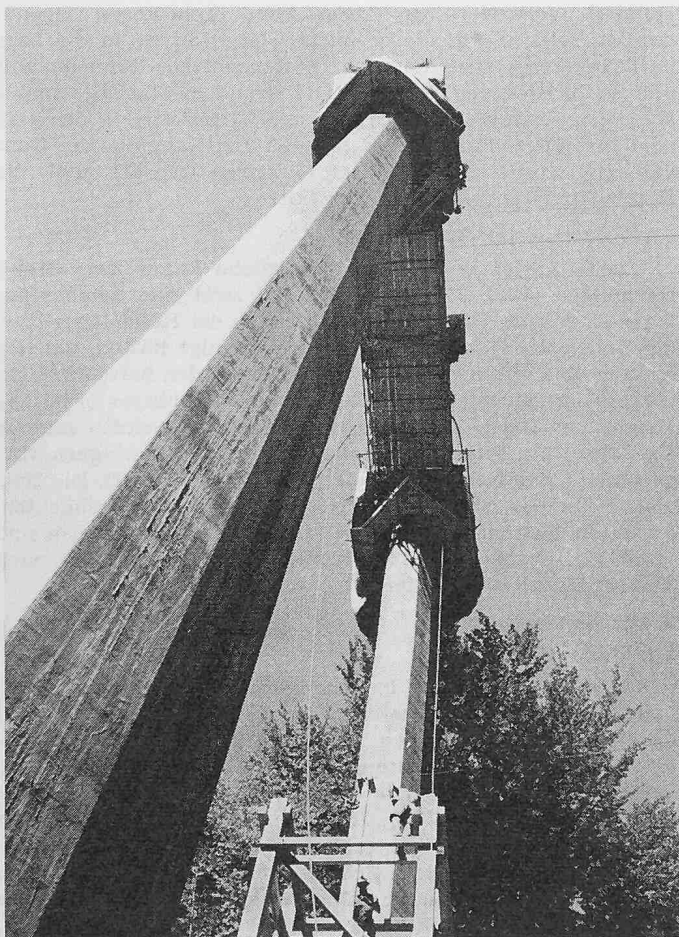
Bild 18. Hochziehen eines Pfeilerpaares mit hydraulisch gesteuerten Stahlgleitschalungen
