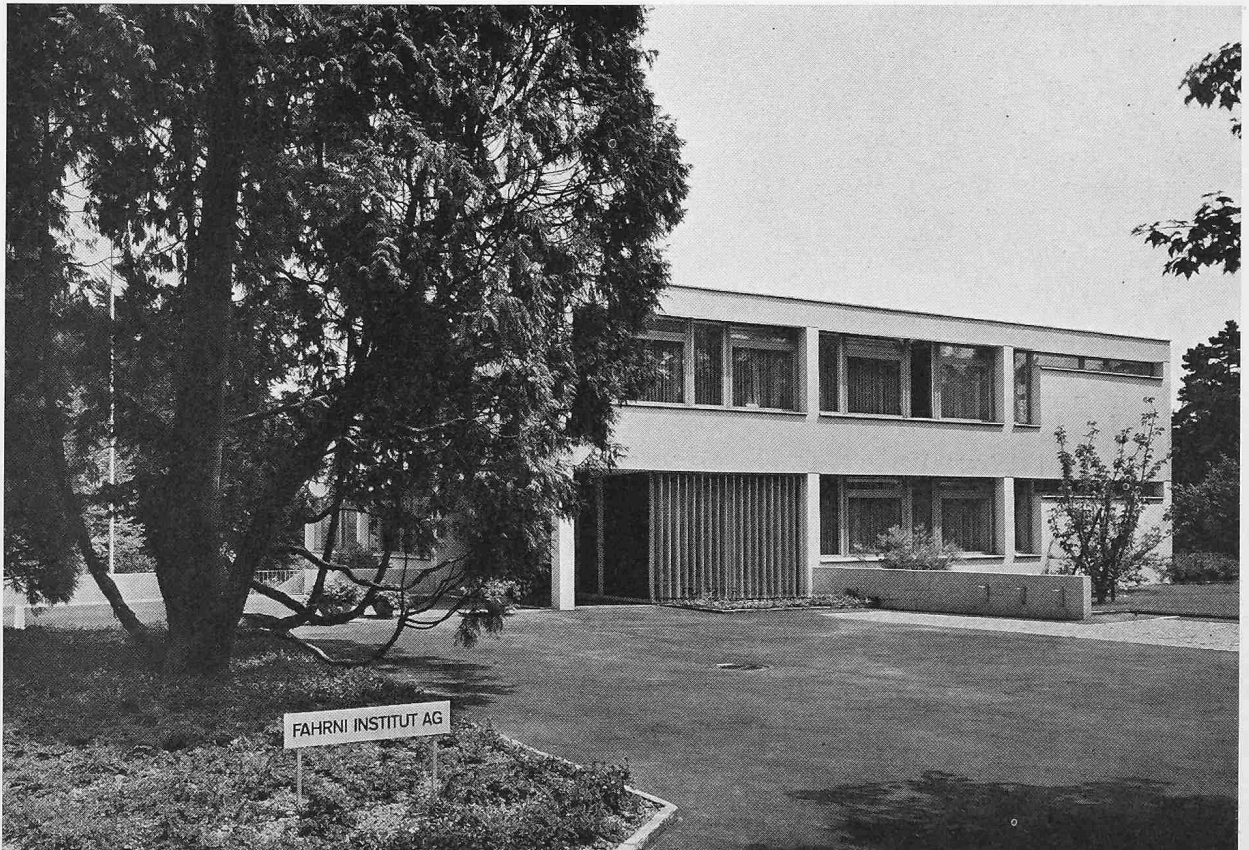
Südwestansicht (Bergseite) des Instituts
