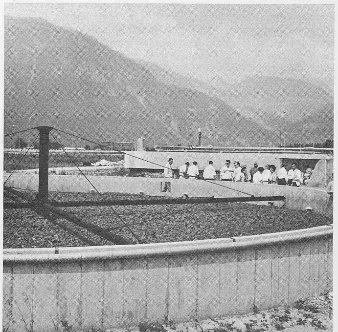
Bild 8. Biologische Wassereinigung: Tropfkörper
