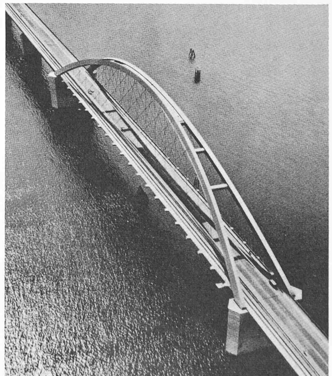
Bild 43. Fehmarnsundbrücke mit bogenüberspannten Balken in der Hauptöffnung
