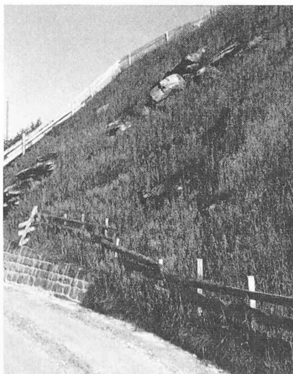
Bild 4. Teilstück des Rutschhanges bei Caprau etwa ein Monat nach Begrünung
