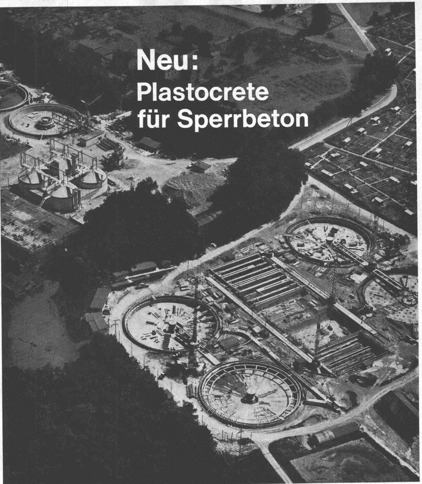
Kläranlage Werdhölzli Zürich
