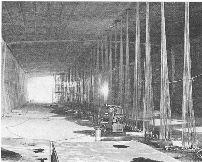
Bild 20. Provisorische Kabel, die als Einzellasten in Feldmitte den im Trockendock fehlenden Wasserdruck ersetzen. Die Kabel werden gleichzeitig mit der Quervorspannung angespannt und während des Absenkens entspannt
