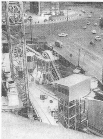
Bild 7. Installationen der Baustelle in Paris. Rechts unten Angriffsschacht mit Doppelaufzug für Personen und Betonfertigteilen der Auskleidung. In Bildmitte Transportbänder für die Förderung des Ausbruchmaterials in den Silo (nicht sichtbar)
