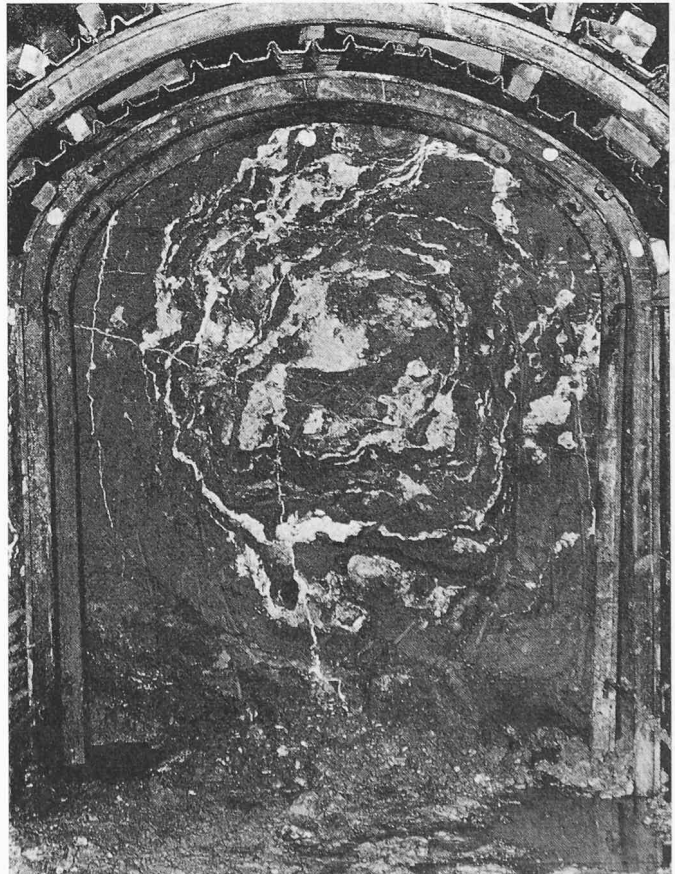
Bild 5. Chemische Injektionen im Kabelstollen PTT-Bern, Ansicht der Stollenbrüst
