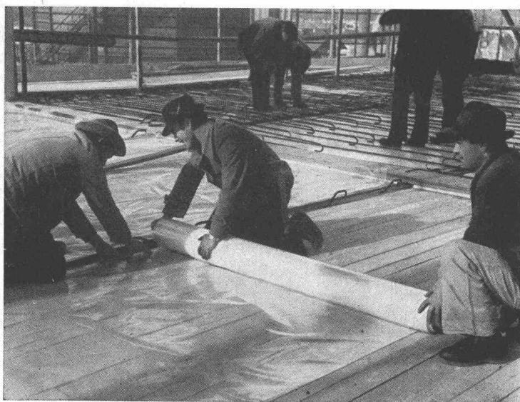
Polyäthylen «Howagaine» im Strassenbau
