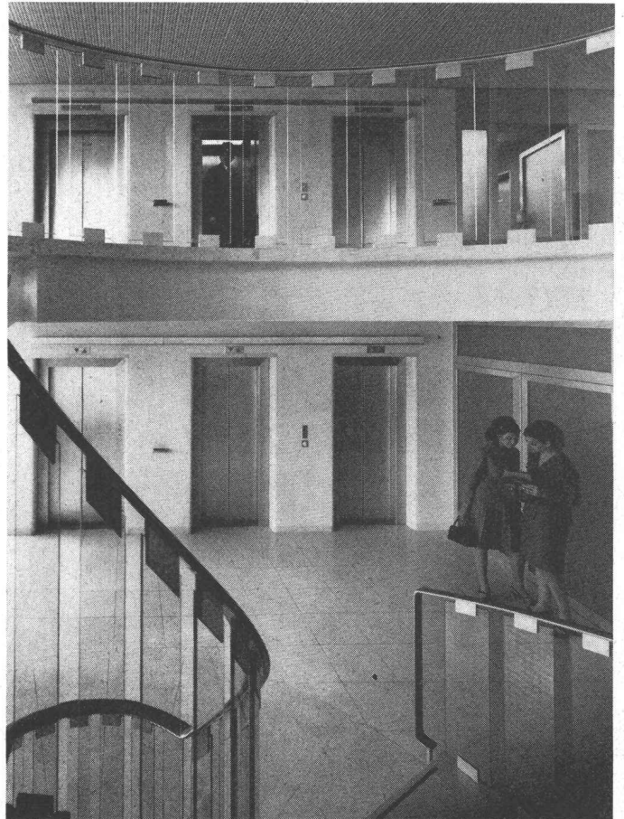
Bild 1. Schindler-Aufzüge mit automatischen, zentralöffnenden Horizontal-Schacht- und Kabinenschiebetüren in einem Verwaltungsgebäude
