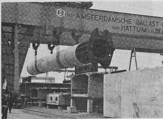
Bild 16. Transport eines Pfahles über das Werkareal
