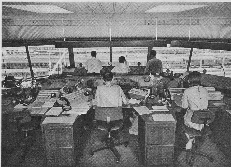
Bild 9 (rechts). Kommandoraum im Befehlsstellwerk
