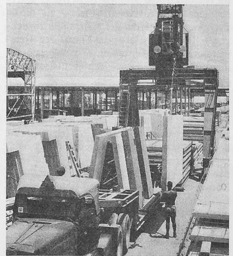
Bild 2. Lagerung und Abtransport der Fertigbauteile
