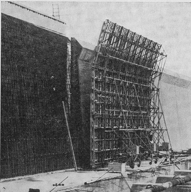
Bauunternehmer ein neues Schalelement zur Verfügung, das einerseits durch Verwendung von Eisenprofilen anstelle von Kanthölzern sowie grossen fugenlosen Schalflächen neue Wege geht, andererseits dem Unternehmer ermöglicht, die bis heute in seinem Betrieb bewährten Schaltafeln weiterhin zu verwenden. Das System wird durch die Firma Construvit AG in Lyss vertrieben.
