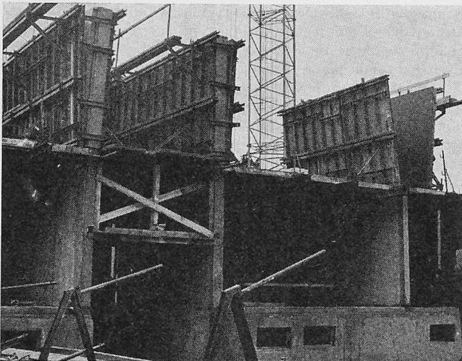
Bild 2. «Konstal»-Grossflächenschalung
