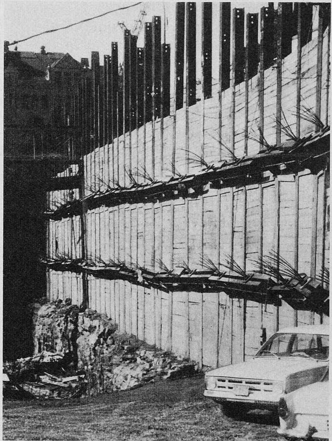
Bild 6. Offene Baugrube mit rückverankerter Wand
