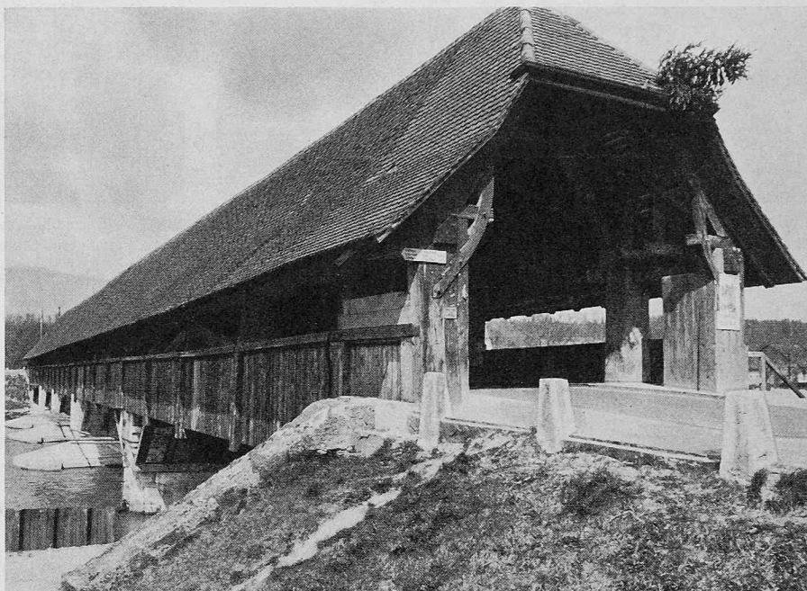
Bild 20. Wangen (1549–52): Widerlager Wangen, Steinpfeiler, drei Betonpfeiler (1967), dazwischen Öffnungen V–I
