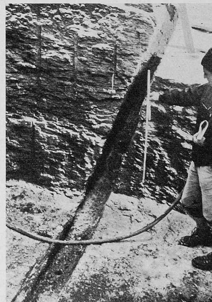
Bild 14. Felskluft unter den Fundamenten der Gipfelstation
