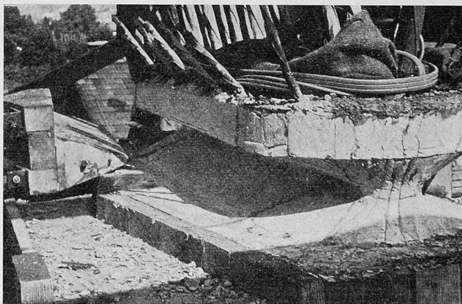
Bild 13. Betongelenk beim Hardturm-Viadukt beim Ausschalen
