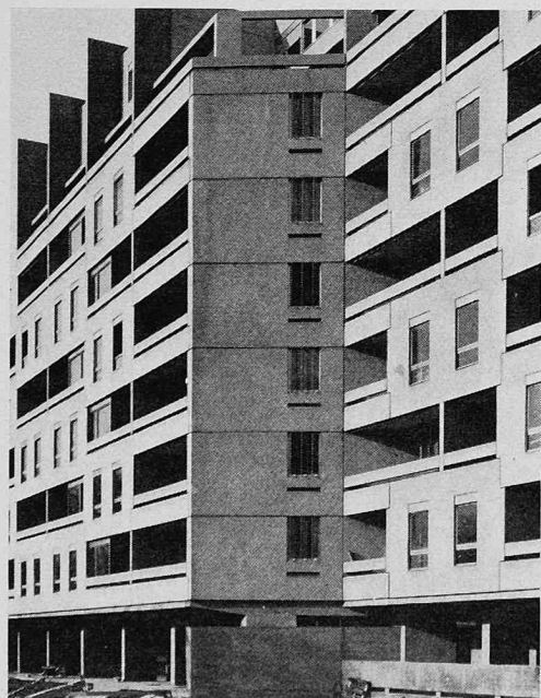
Immeubles Type A, détail de façade
