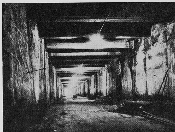
Bild 10: Tiefbahn Wien: Tunnel mit seitlichen Schlitzwänden
