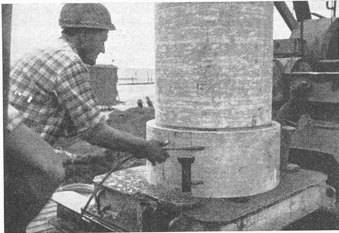
Bild 3. Einführung des als Scherkörper wirkenden Chromstahlseiles in die Ringnut der zugfesten Steckmuffe bei Vertikal-Brunnenrohren
